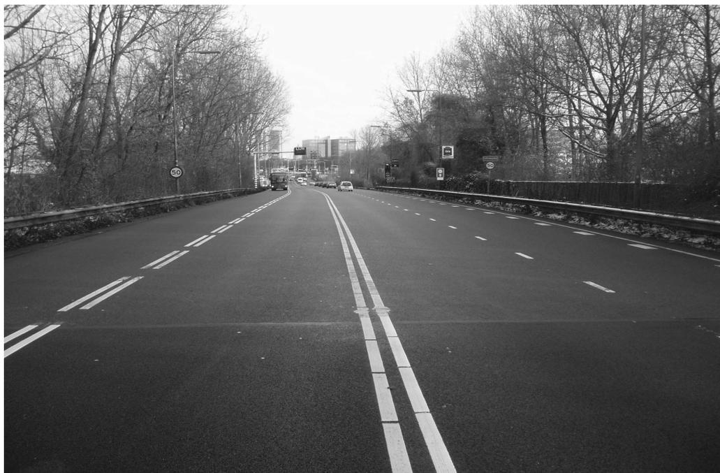
De rijweg heeft bij dit wegvak een totale breedte van 14 meter (4 x 3,5 meter). De afstand van de rand van de weg tot de as van de weg is dus 7 meter. Bij de voorgeschreven afstand voor het rekenpunt van 5 meter van de rand van de weg, kom je dus in totaal op 12 meter. Die afstand is de afstand tot de wegas die tot 2007 moest worden aangehouden. En niet 16 of 24 meter en al helemaal niet 30 meter, zoals bij wegvak v4/sL is gebeurd.
